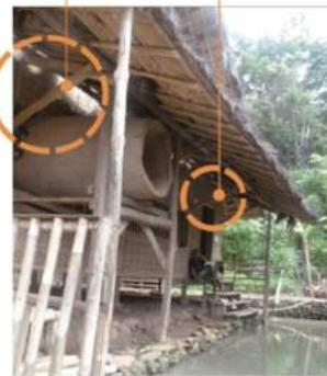
Atap terbuat dari kuda-kuda kayu, dengan kaso dan reng yang terbuat dari bambu, dan penutup atap daun hateup yang kemudian dilapisi ijuk.
