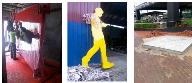
Rajah 10: Kerja mengecat powder coating dan penyediaan tapak di lokasi.
