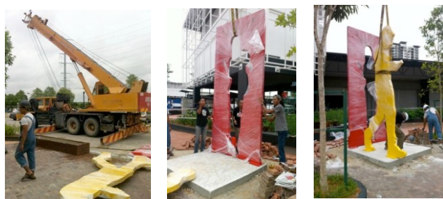
Rajah 11: Proses instalasi karya dengan bantuan kren.
