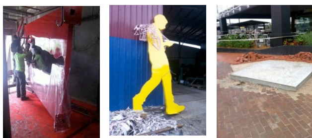
Rajah 10: Kerja mengecat powder coating dan penyediaan tapak di lokasi.
